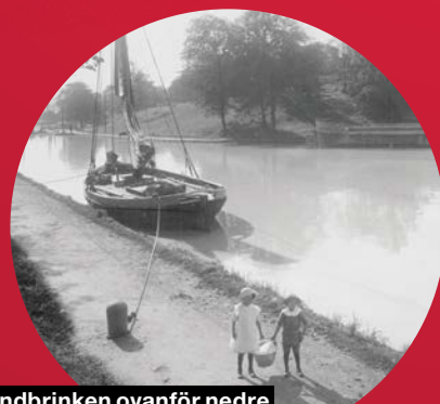
Strandbrinken ovanför nedre slussen i Ström före ombyggnaden.
